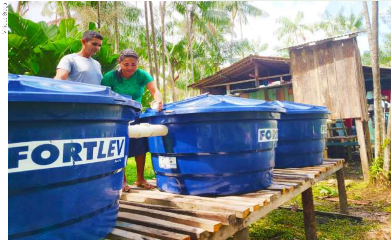
Joelma e Paulo Anjos durante instalação da fossa séptica biodigestora
